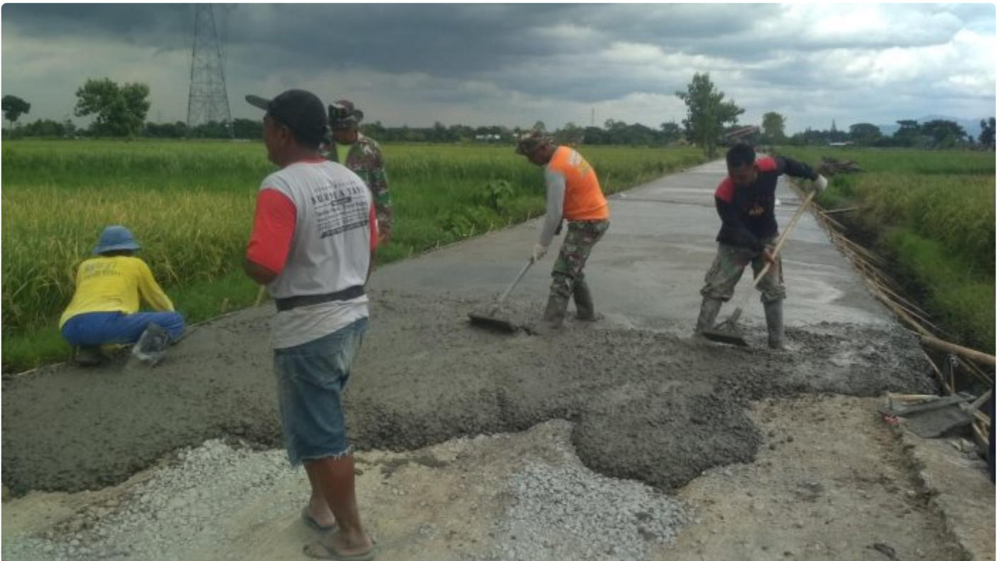
Puasa Bukan Halangan Bagi Satgas TMMD Kodim 0723 Klaten
